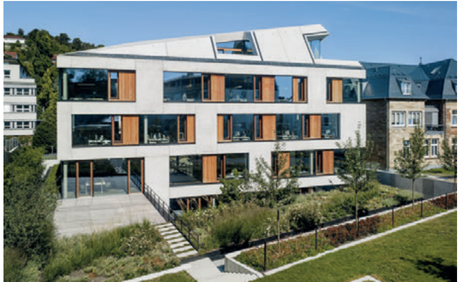
Architektur mit hervorragender Arbeitsplatzqualität – ausgezeichnet beim Beipielhaften Bauen: Bürogebäude Stuttgart-Nord | Architekten: Blocher Blocher Partners, Architecture and Design, Stuttgart; Landschaftsarchitekten: Landschaftsarchitektur Glück, Stuttgart
