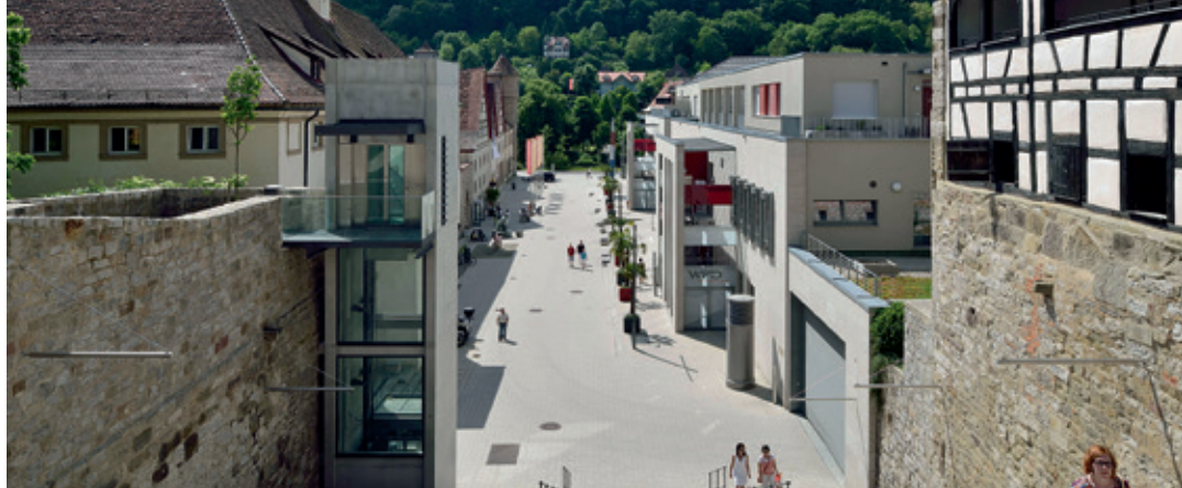
Gute öffentliche Räume sind die Herausforderung der Zeit. Im Bild der Froschgraben in Schwäbisch Hall. Früher war hier Parkplatz.
