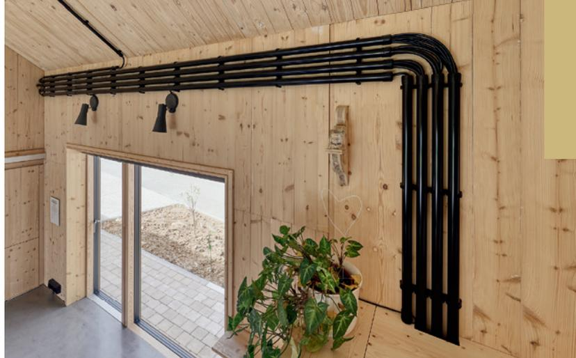
**Das Einfamilienhaus in Böhmenkirch (Kreis Göppingen) besticht durch Sparsamkeit: einfache Materialien, reduzierte Formensprache, Verzicht auf alles Überflüssige, sichtbare Holzkonstruktion, kernaktivierte Bodenplatten, Aufputz-Installationen. Ein konsequenter, preiswerter Bau.**
