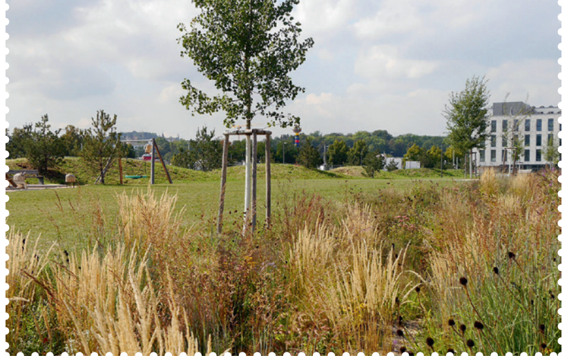
Im Veielbrunnenpark in Stuttgart werden Dach- und Oberflächenwasser in einer Retentionsmulde gesammelt. Die große Verdunstungsrate wirkt dem Wärmeineffekt entgegen.
